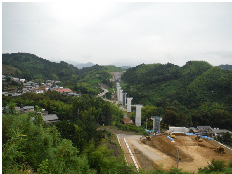
中部横断自動車道の整備状況
