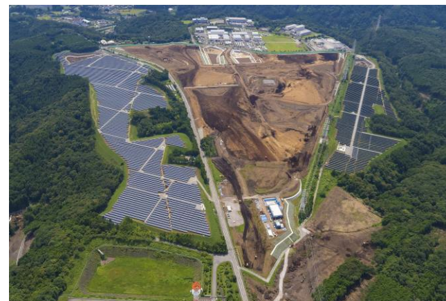
工業団地と 太陽光発電施設
