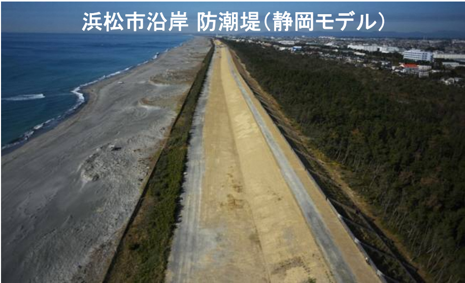
浜松市沿岸域の防潮堤の整備状況
