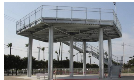
津波避難施設
