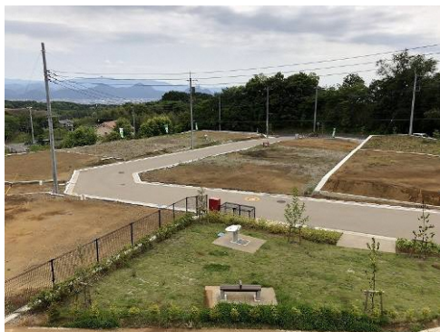
整備が完了した 住宅団地(市山新田)
