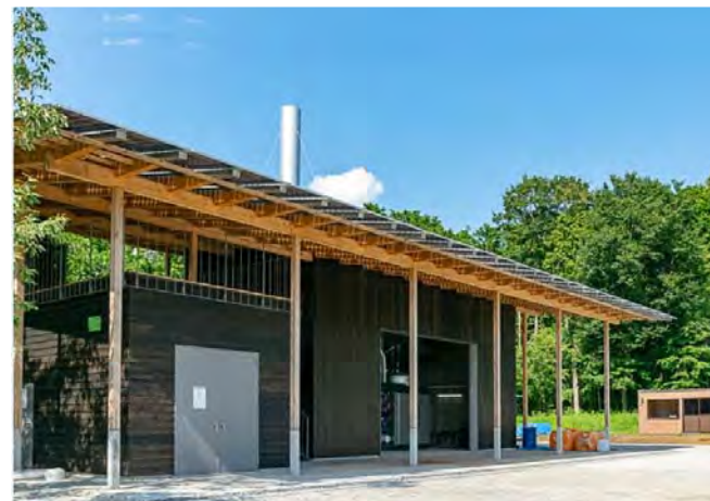
木質バイオマス 発電所
