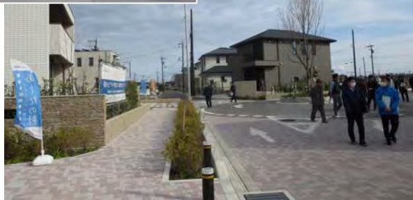
住居の建築が進む住宅地
