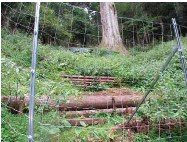
土砂の流出を防ぐための措置とシカ除けの防護柵（伊豆市：天城の太郎スギ）
