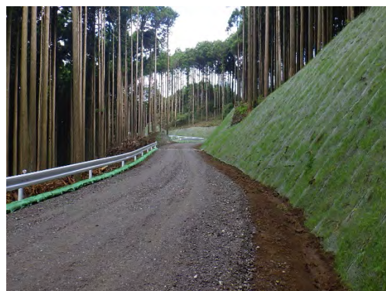
養生マットによる法面緑化
