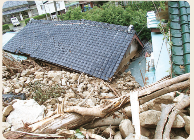
▲令和4年8月に発生したがけ崩れ(松崎町)
